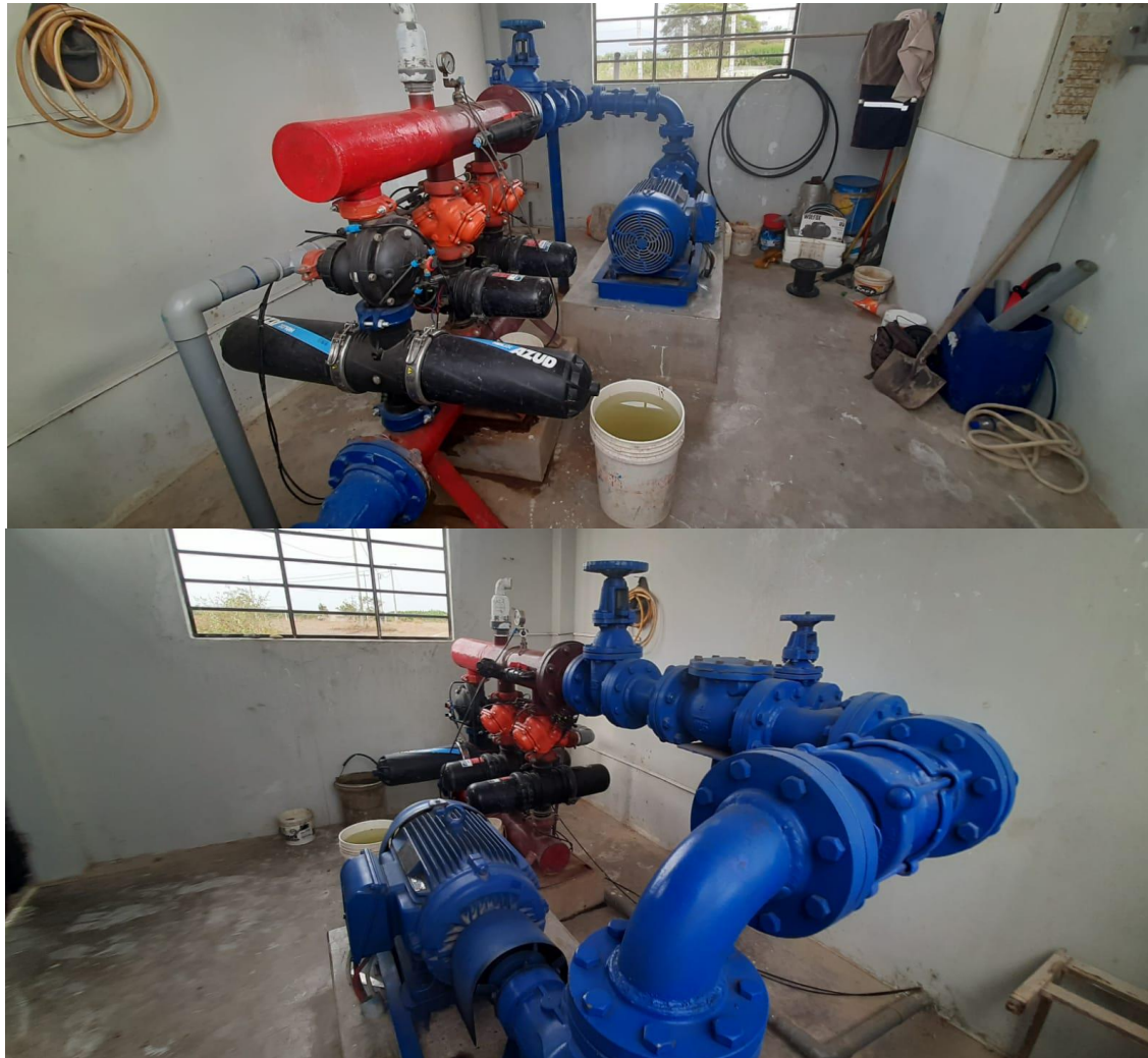
Anexos 5. Interior del cabezal de filtrado que cumple la función de regar todos los cultivos existentes en el CET.
