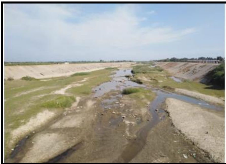
Figura 7. Se observa el dimensionamiento del cauce aguas arriba del puente Bolsico.
