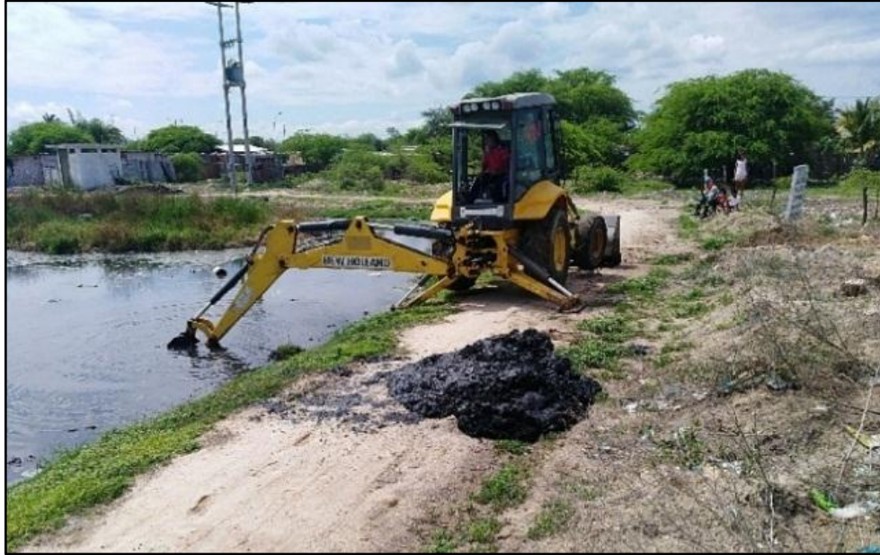
Figura 3: Extracción de lodo crudo de uno de los puntos de muestreo de la laguna de Campo Amor.
