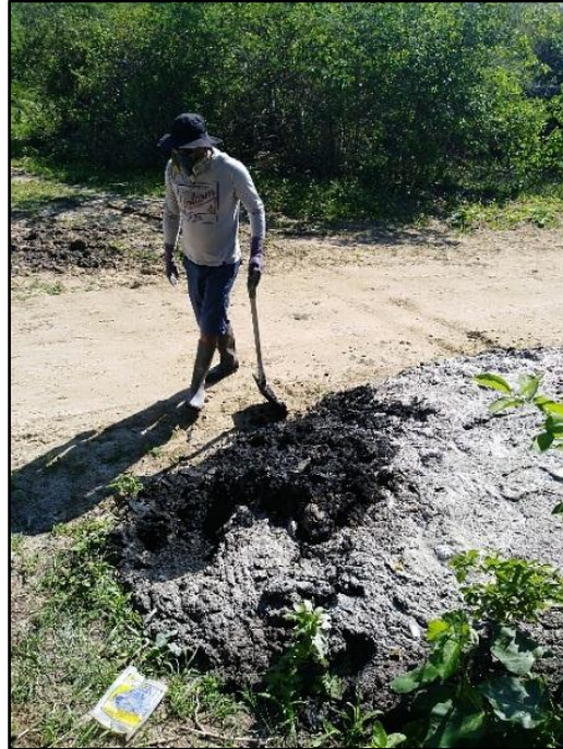
Figura 5: Aplicación de CAL al lodo crudo para su estabilización.
