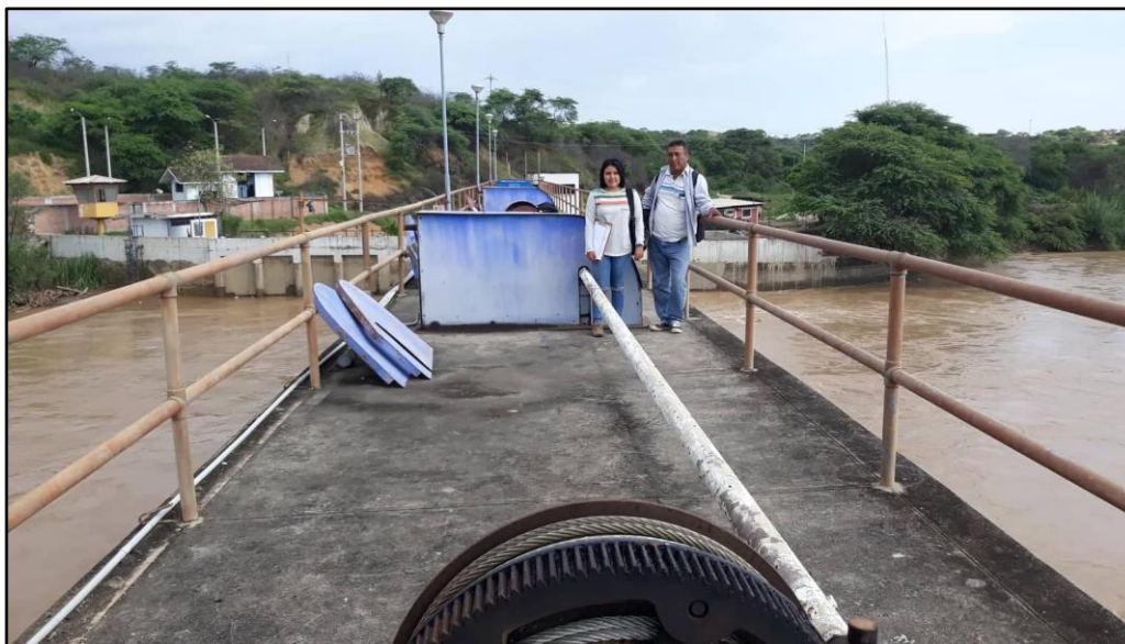
Fotografía: 2 Bocatoma "La Peña"
