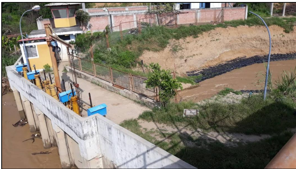
Fotografía: 1 Canal de Derivación "Margen Izquierda"
