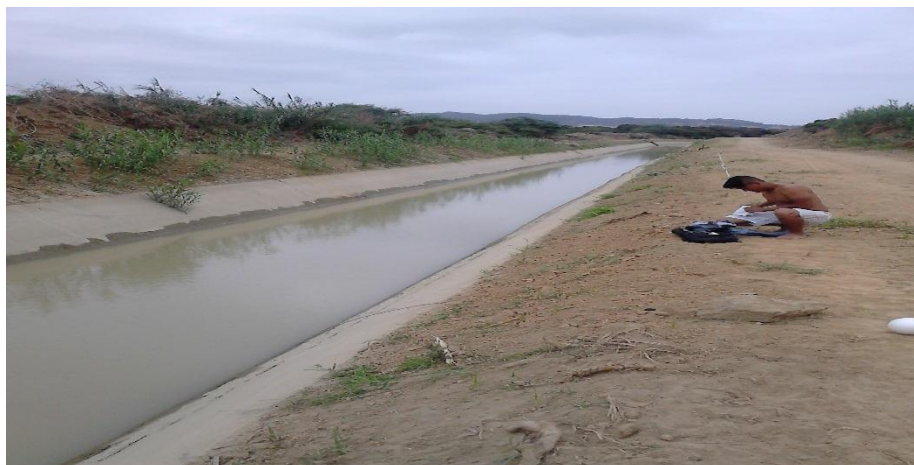
Foto 10. Aforando el Canal Revestido utilizando el Método del Flotador
