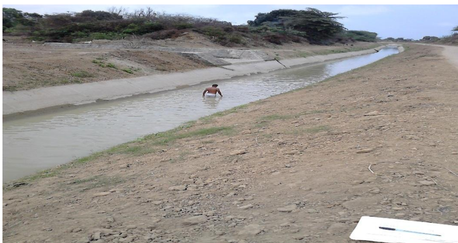
Foto 11. Medición de la Sección Hidráulica del Canal Revestido
