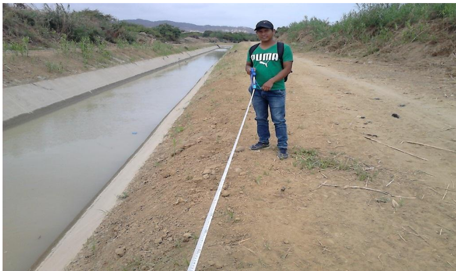
Foto 8. Medición de los 500 m del Canal Revestido Sector Los Cedros
