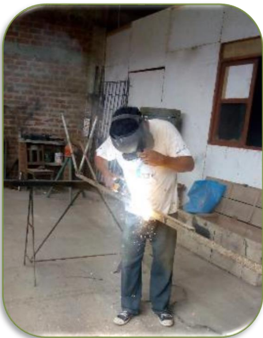
Foto 7. Armado de la estructura de soporte de la bomba de espiral.
