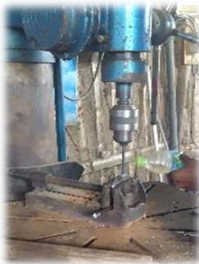
Foto 4. Perforación de los anillos de acero para colocar los prisioneros.
