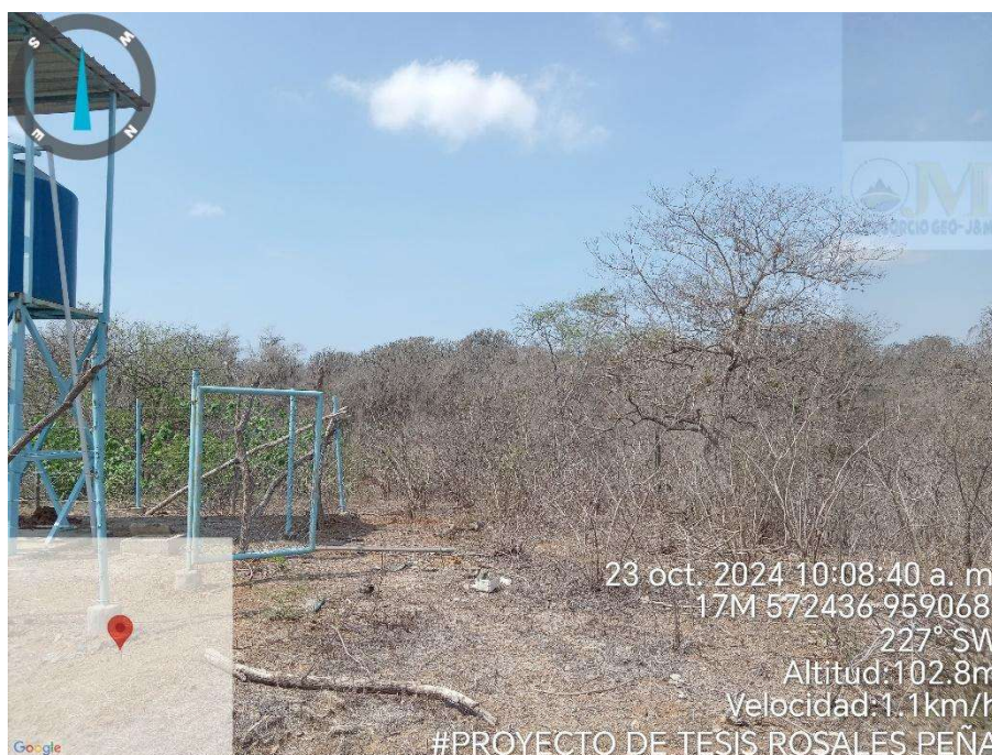
Imagen 4. Cerco perimétrico del almacenamiento de agua potable.
