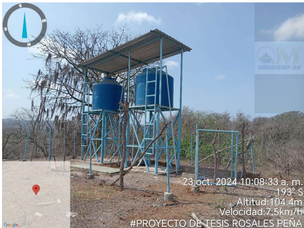
Imagen 11. Cerco perimétrico del reservorio del centro poblado Chacritas.
