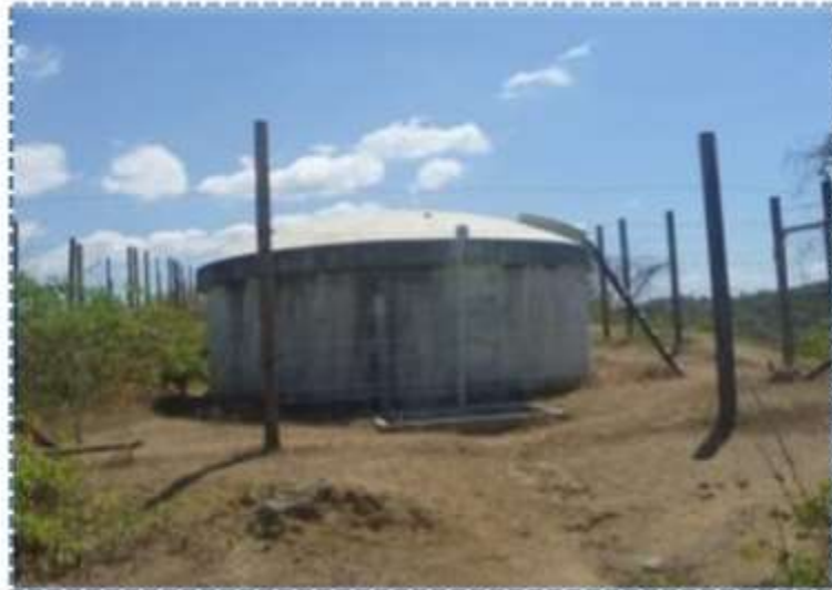
Foto N°13: TANQUE ELEVADO DE RICA PLAYA
