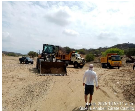
Foto N.º 14 Presencia de maquinaria pesada para la extracción de material de acarreo.
