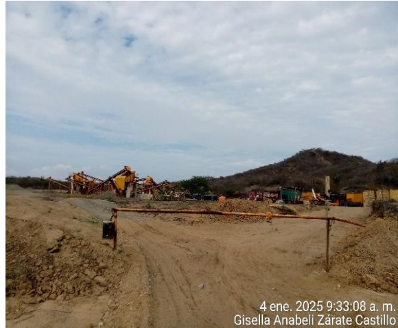
Foto N.º 08. Presencia de maquinaria pesada e infraestructura instalada para la extracción de material de acarreo. 4 ene. 2025 9:33:08 a. m. Gisella Anabeli Zárate Castillo
