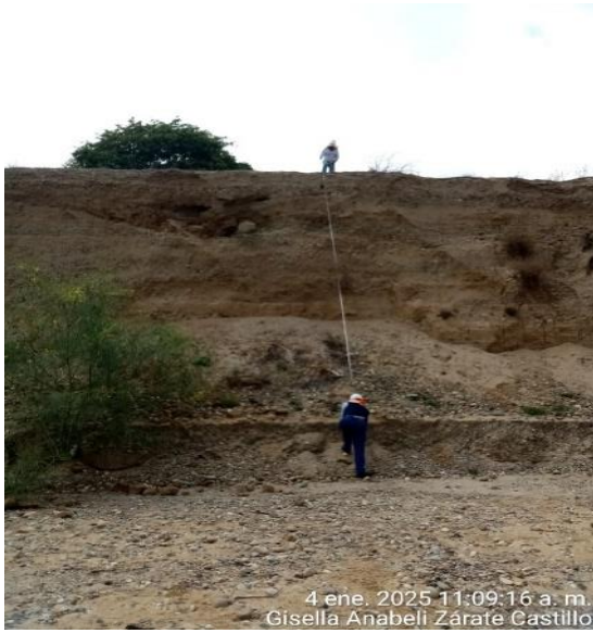
Foto N° 17. Medición de las alturas de los socavones existentes generados por la extracción de material de acarreo
