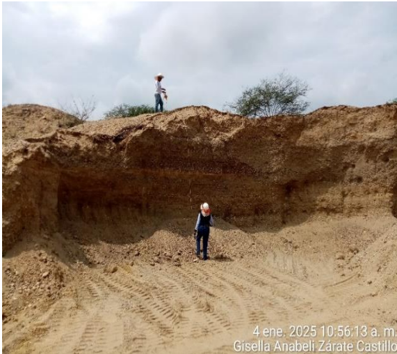
Foto N.º 13 Medición de las alturas de los socavones existentes generados por la extracción de material de acarreo
