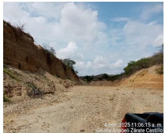
Foto N.º 16. Socavones existentes generados por la extracción de material de acarreo
