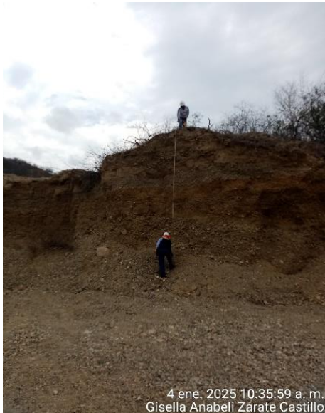
Foto N.º 09. Medición de las alturas de los socavones existentes generados por la extracción de material de acarreo 4 ene. 2025 10:35:59 a. m. Gisella Anabeli Zárate Castillo
