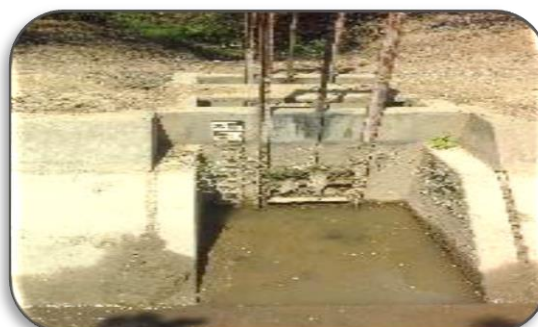
Foto 56: estructura de control de la infraestructura hidráulica de riego Higuerón.
