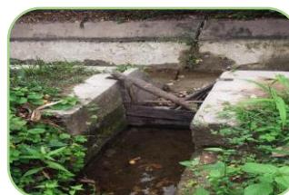
Foto 94: estructura de control no cuenta con compuerta de la infraestructura hidráulica de riego de Casa Blanqueada.
