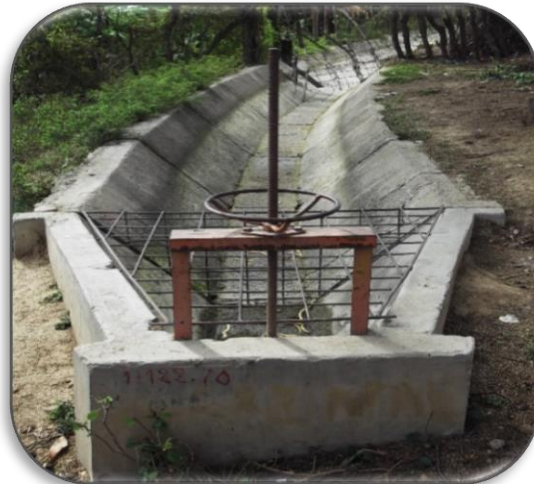
Foto 20: un tramo del canal cubierto con una losa de concreto de forma abovedada de la infraestructura hidráulica de riego Oidor.
