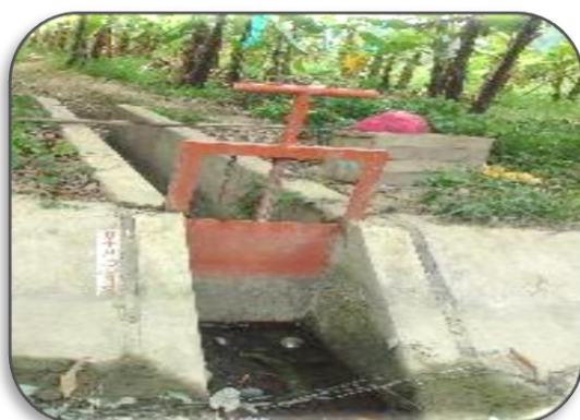
Foto 57: estructura de control de la infraestructura hidráulica de riego Higuerón.
