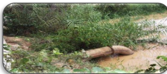
Foto 10: canal aductor de la infraestructura hidráulica de riego de Oidor.
