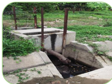
Foto 88: compuerta aforada de la infraestructura hidráulica de riego de Casa Blanca.
