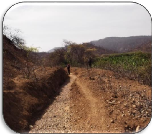
Foto 25: lateral N° 5 de la infraestructura hidráulica de riego de Rica Playa.
