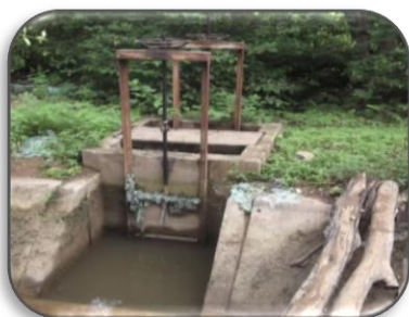
Foto 31: lateral N° 01, de la infraestructura hidráulica de riego Casa Blanqueada.
