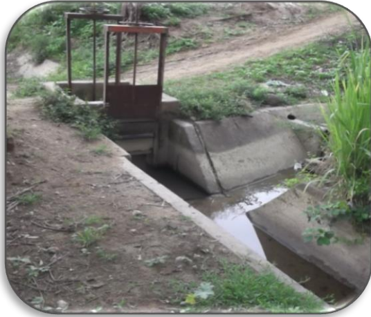
Foto 17: el canal principal da un giro de 90° y la sección regresa a su forma trapezoidal de la infraestructura hidráulica de riego Casa Blanqueada.
