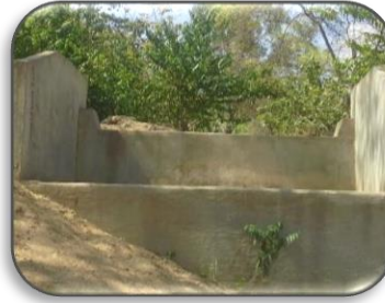
Foto 68: canal con cubierta de concreto de forma abovedada y muros de gaviones de la infraestructura hidráulica de riego de Oidor.
