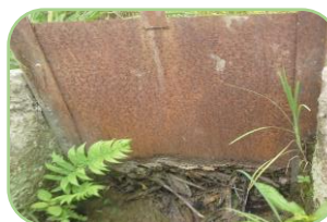
Foto 94: estructura de control no cuenta con compuerta de la infraestructura hidráulica de riego de Casa Blanqueada.
