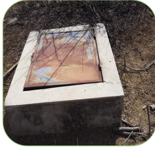
Foto 98: salida del sifón de la infraestructura hidráulica de riego Higuerón.
