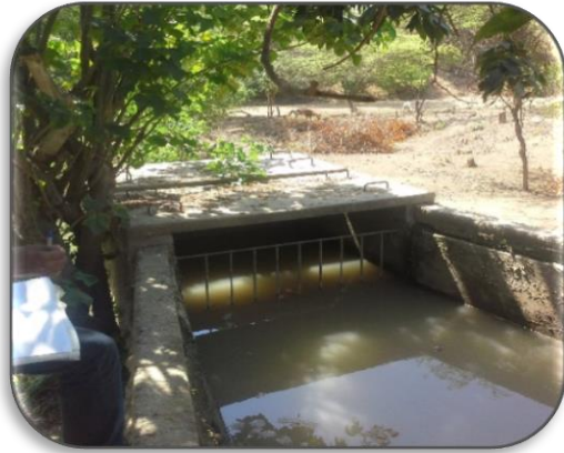
Foto 14: el canal de derivación de la infraestructura hidráulica de riego de Higuierón.
