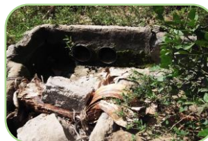
Foto 90: toma parcelarias de la infraestructura hidráulica de riego de Rica Playa.
