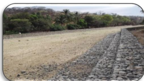
Foto 63: muro de gaviones en ambas márgenes de quebrada carrillos de la infraestructura hidráulica de riego de Rica Playa
