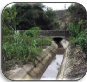
Foto 69: canal con cubierta de concreto de forma abovedada y muros de gaviones de la infraestructura hidráulica de riego de Oidor
