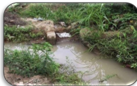
Foto 60: toma de concreto en lateral N° 01-i. De la infraestructura hidráulica de riego de Oidor.
