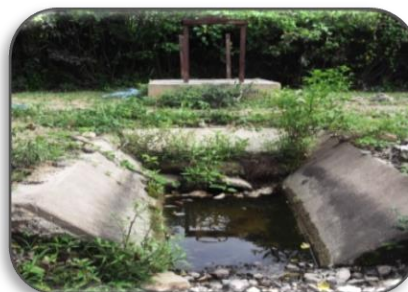
Foto 32: lateral N° 04, de la infraestructura hidráulica de riego Rica Playa.
