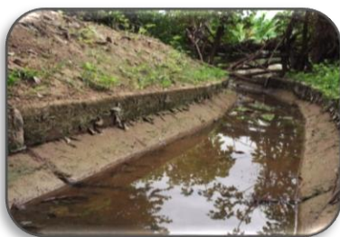
Foto 51: medidor parshall de la infraestructura hidráulica de riego de Casa Blanqueada.
