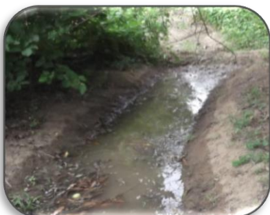
Foto 45: lateral N° 02, de la infraestructura hidráulica de riego de Oidor.
