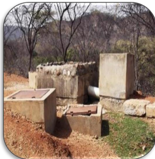
Foto 24: la poza de descarga (poza de disipación), funcionan a gravedad como conductos entubados. De la infraestructura hidráulica de riego Rica Playa.
