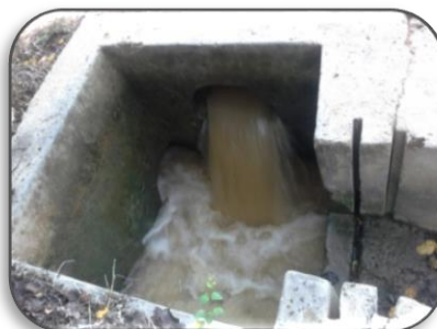
Foto 42: poza de descarga lateral 01-d.de la infraestructura hidráulica de riego de Oidor.
