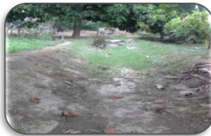
Foto 30: lateral N° 04 de la infraestructura hidráulica de riego de Higuerón.
