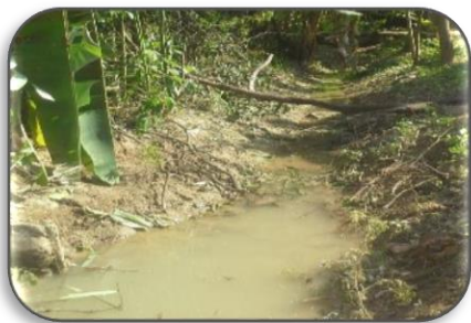
Foto 29: lateral 03, de la infraestructura hidráulica de riego de Higuerón.
