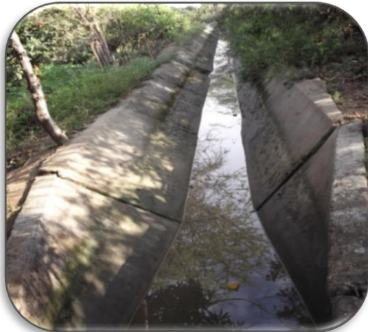
Foto 19: luego de la caída inicia el tramo del canal con sección trapezoidal de la infraestructura hidráulica de riego Oidor.
