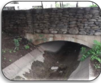
Foto 69: canal con cubierta de concreto de forma abovedada y muros de gaviones de la infraestructura hidráulica de riego de Oidor
