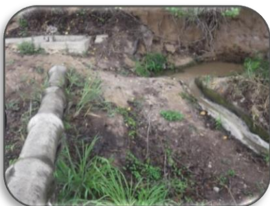
Foto 43: acueducto semicircular mediante una toma lateral de la infraestructura hidráulica de riego Oidor.
