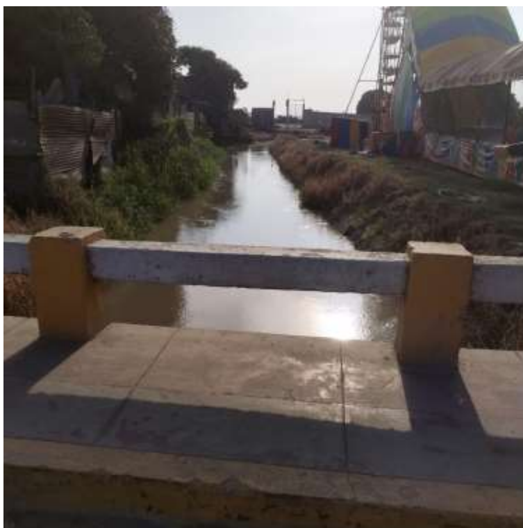
Anexo 6: Canal irrigación Margen Izquierda actual ramal la cruz pasando por el casco urbano del distrito de Corrales, Sector la Garita, obsérvese las viviendas en ambas márgenes y el puente que une la Garita con Centro de Corrales
