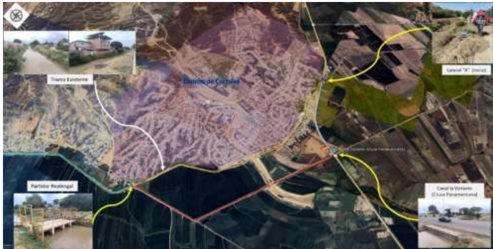
Fig. 1: Tramo actual del Canal Margen Izquierda del río Tumbes
