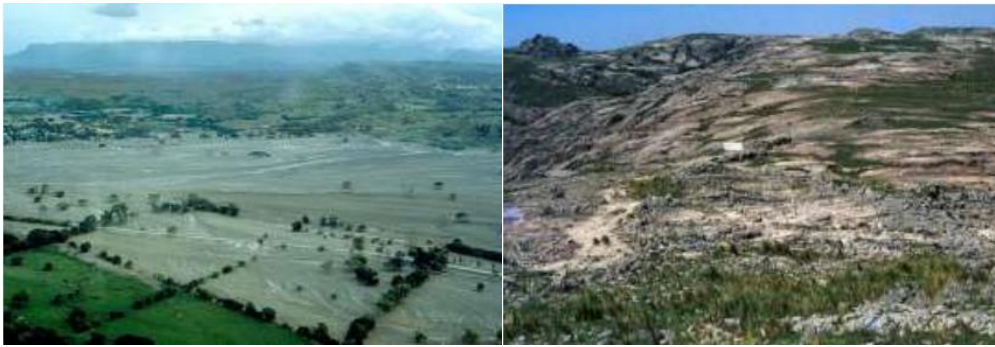
Figura 4: Erosión por movimiento de masa
