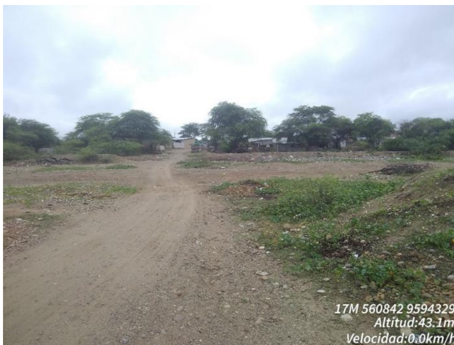
Anexo 38: Viviendas en zona de riesgo – Margen Izquierdo de la quebrada La Peña
