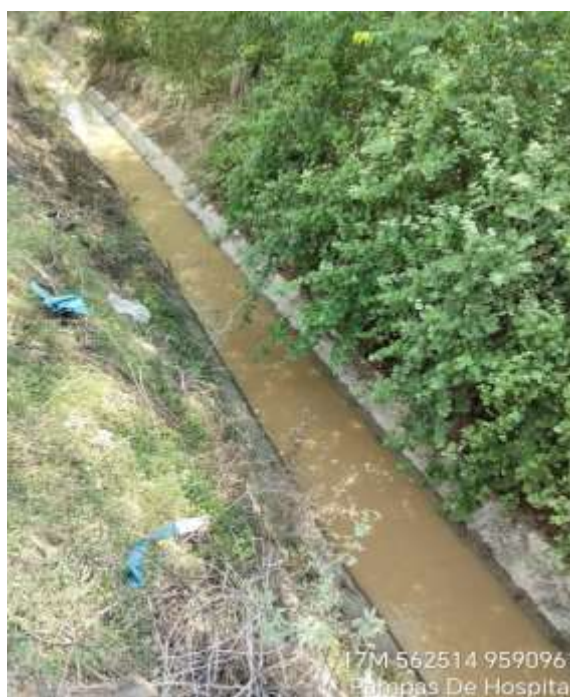
Figura 32: Canal Limpio tramo 1 – Lateral 3
