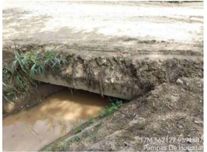
Figura 73: Puente N°4 Lateral 1 Canal de Derivación
