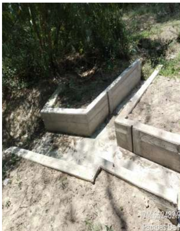
Figura 70: Partidor Lateral 13
