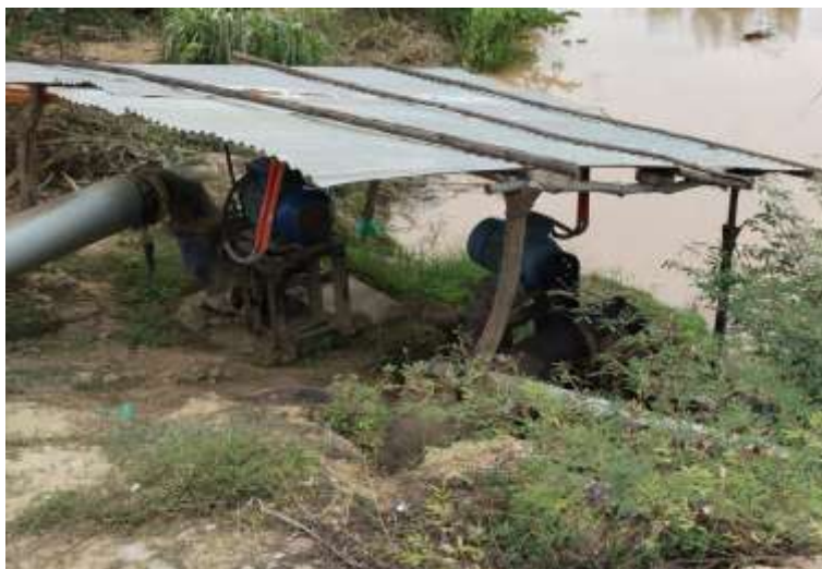
Figura 7, Caseta de bombeo
