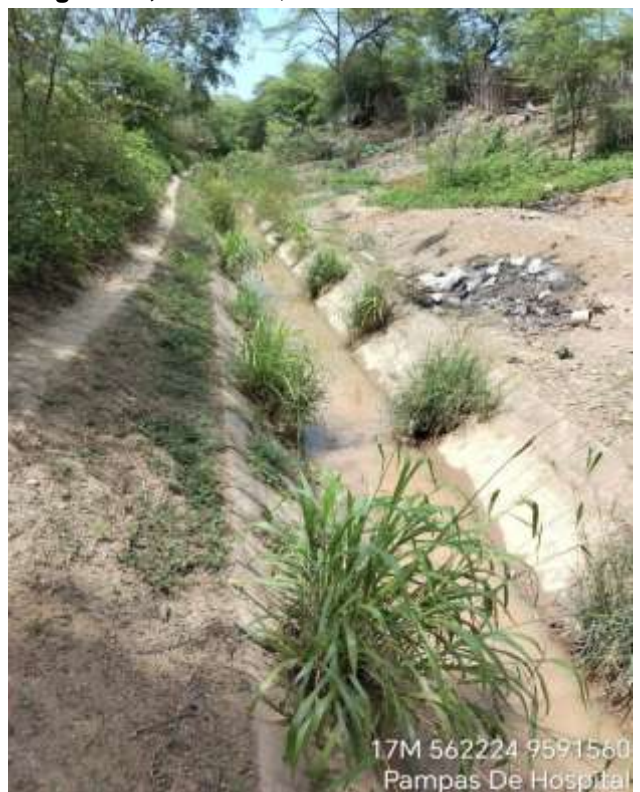
Figura 20, Tramo 06, canal de derivación
