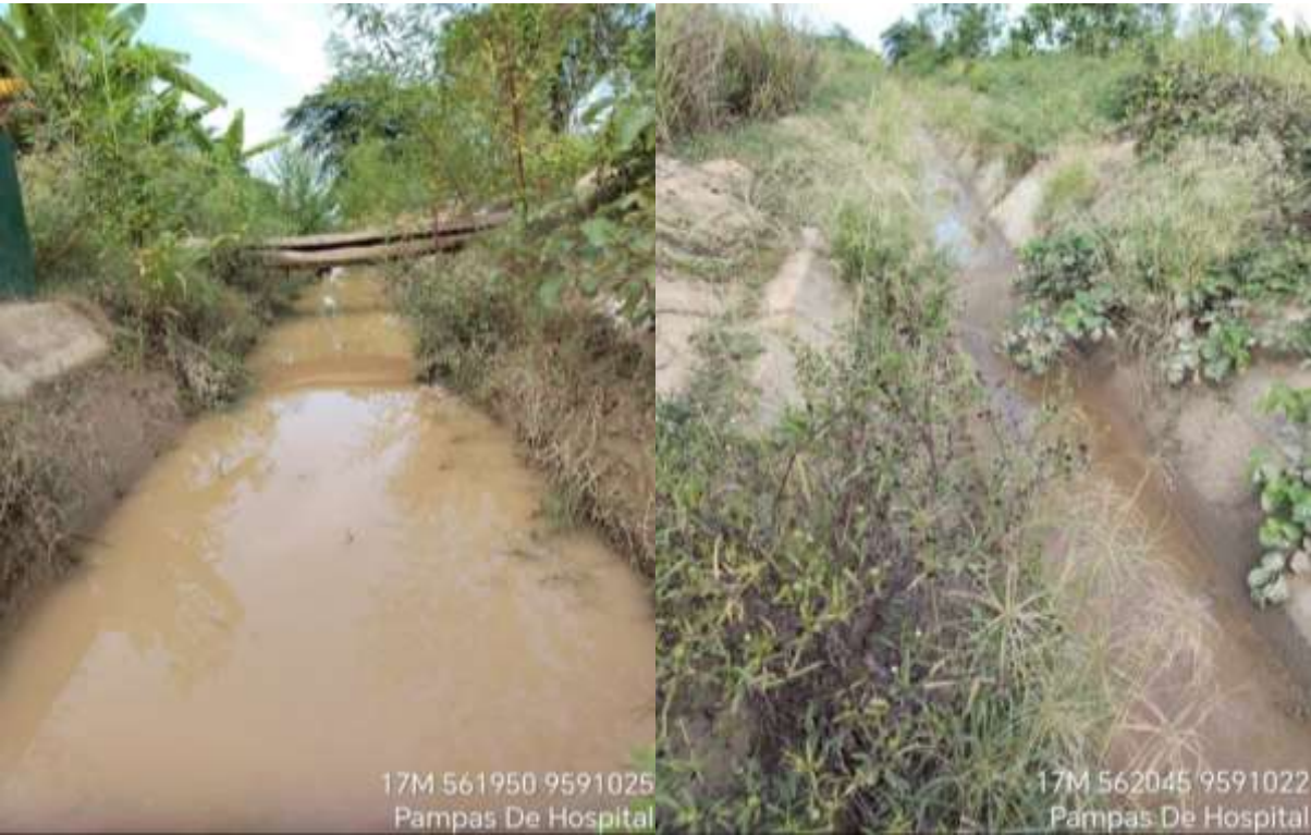
Figura 14: Tramo 01, canal de derivación
