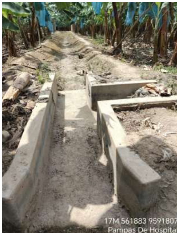
Figura 68: Partidor Lateral 05
