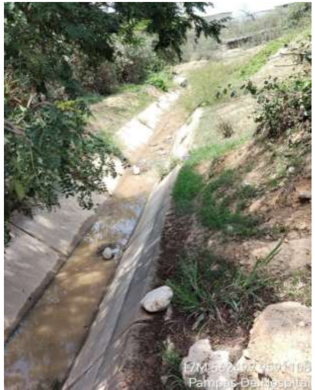
Figura 18: Tramo 04, canal de derivación
