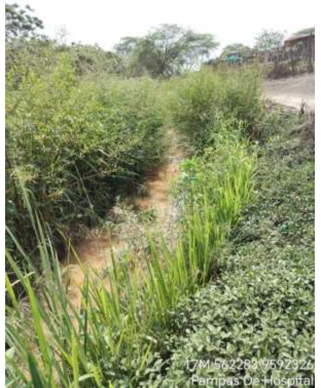
Figura 22, Tramo 08, canal de derivación
