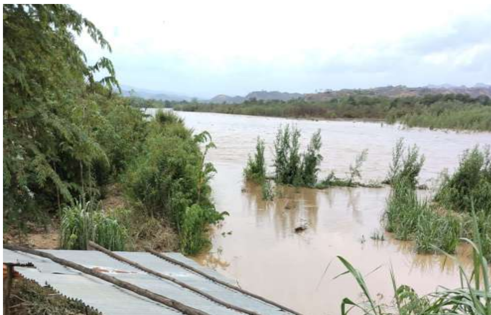
Figura 4, Canal aductor de la comisión Santa María – Pampas de Hospital
