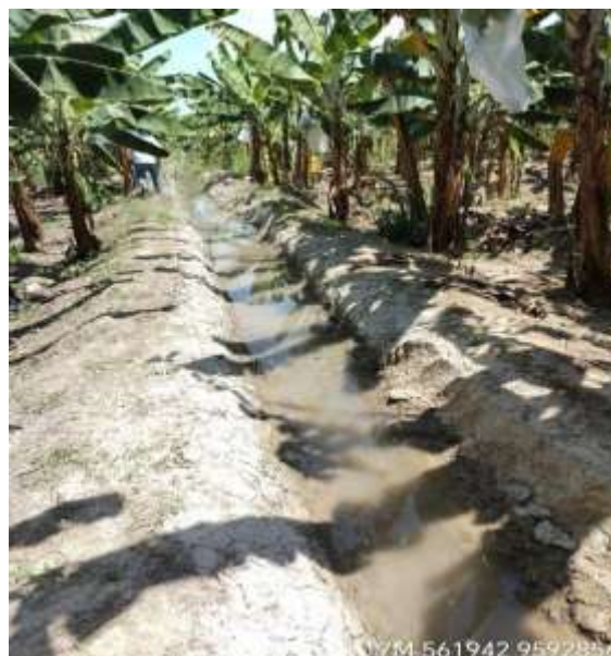
Figura 52: Canal limpio tramo 2 – Lateral 11
