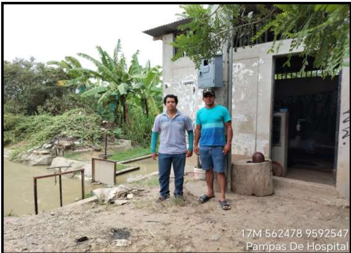
Anexo 27: Evaluación a la estación de rebombeo junto al segundo motorista
