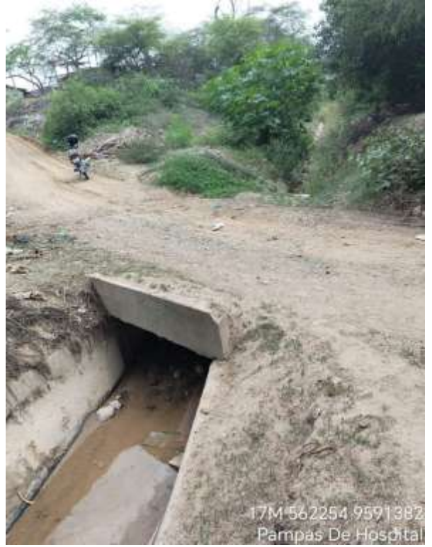
Figura 72: Puente N°2 Canal de Derivación
