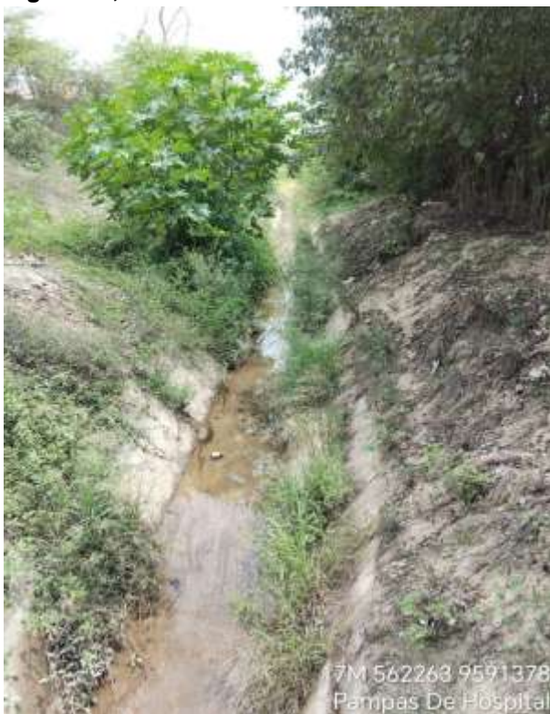
Figura 19, Tramo 05. canal de derivación
