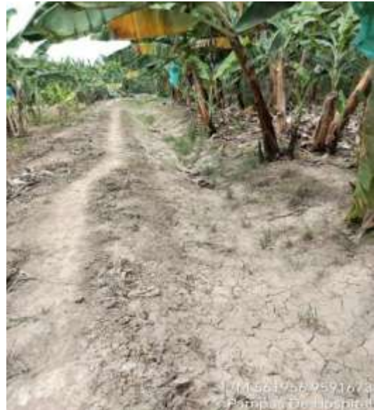
Figura 34: Canal limpio tramo 2 – Lateral
