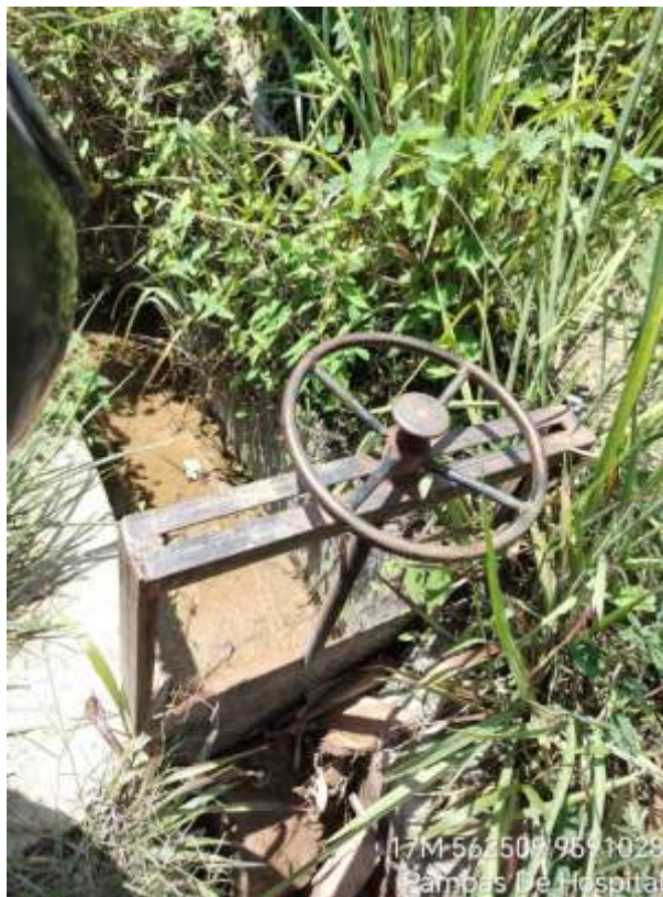
Figura 84: Evidencia 03 Compuerta Inicio L3
