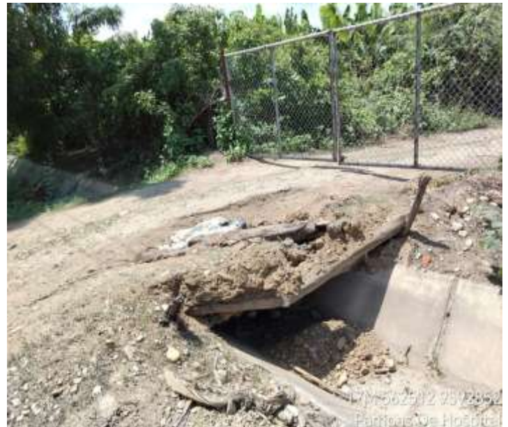
Figura 78: Puente N°8 Canal Lateral 13
