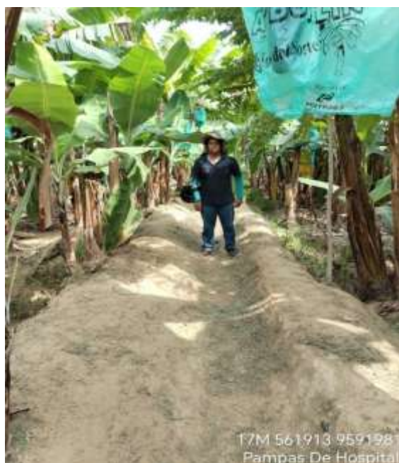
Figura 37: Canal Limpio tramo 1 – Lateral 6
