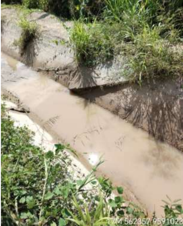
Figura 16: Tramo 03, canal de derivación
