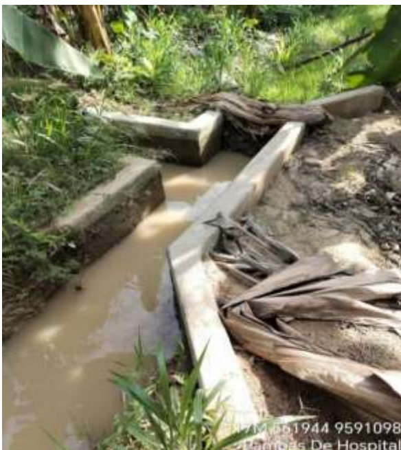
Figura 65: Partidor Lateral 1
