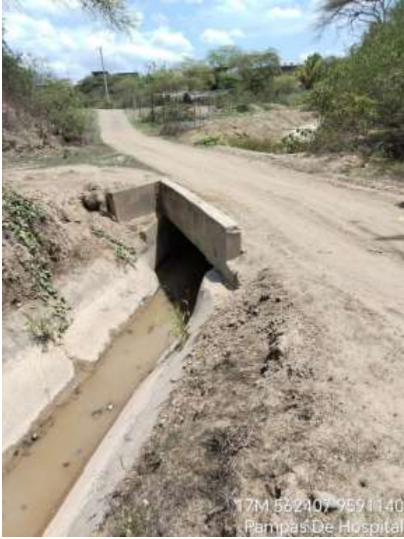
Figura 71: Puente N°1 Canal de Derivación
