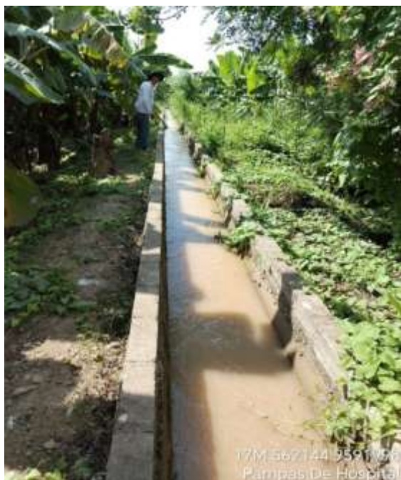
Figura 39: Canal Limpio tramo 1 – Lateral 7
