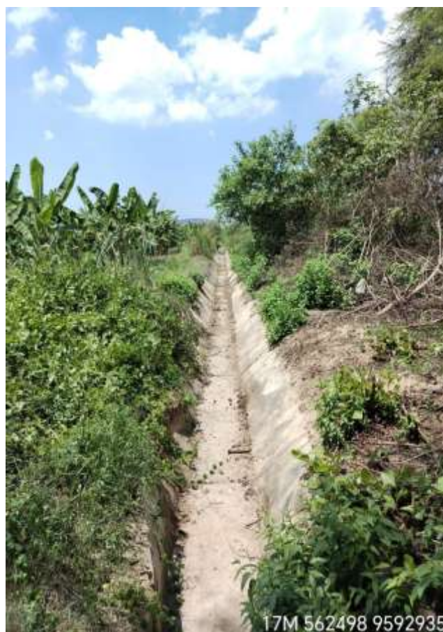
Figura 58: Canal limpio tramo 2 – Lateral 13
