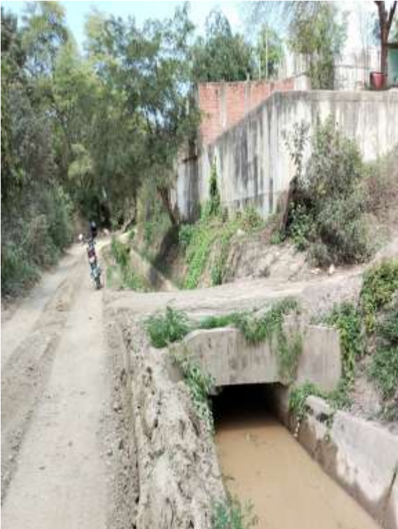
Figura 74: Puente N°3 Canal de Derivación
