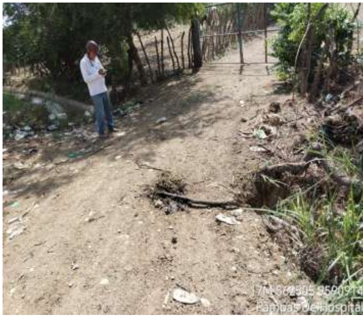
Figura 75: Puente N°6 Canal Lateral 3
