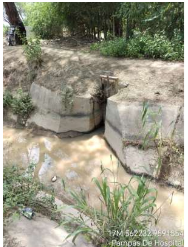
Figura 85: Evidencia 04 Compuerta Inicio L5
