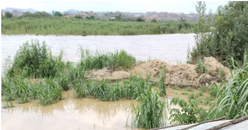
Figura 5, Canal aductor de la comisión Santa María – Pampas de Hospital
