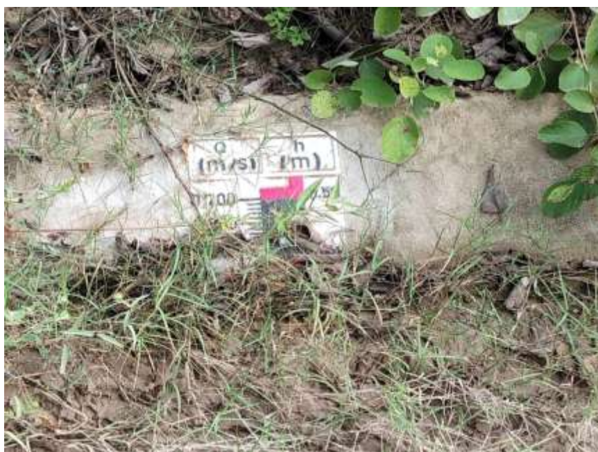
Figura 79: Cinta medidora de caudal del RBC
