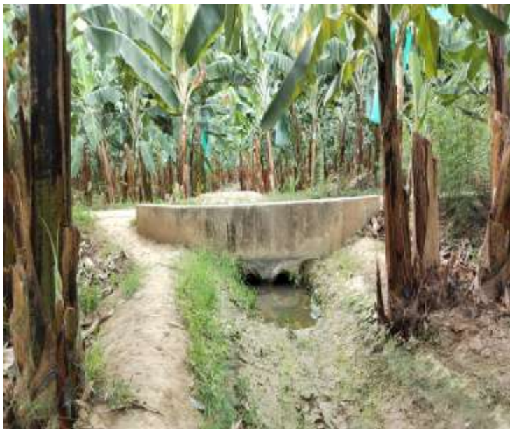
Figura 77: Puente N°7 Canal Lateral 7
