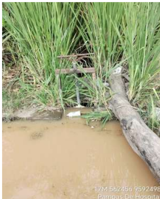
Figura 87: Evidencia 06 Compuerta Inicio L10
