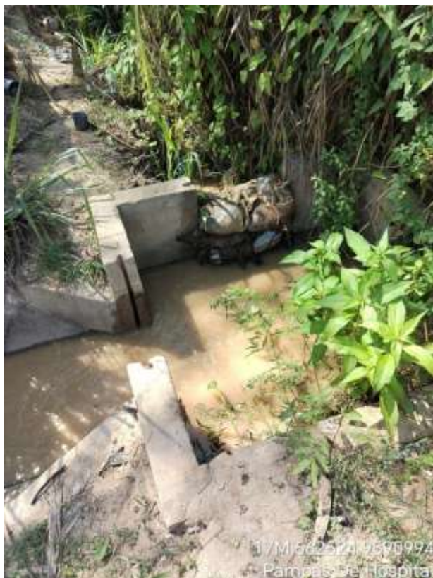
Figura 67: Partidor Lateral 03
