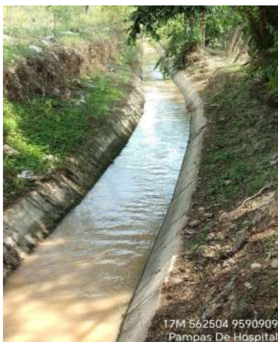
Figura 31: Canal Limpio tramo 1 – Lateral 3
