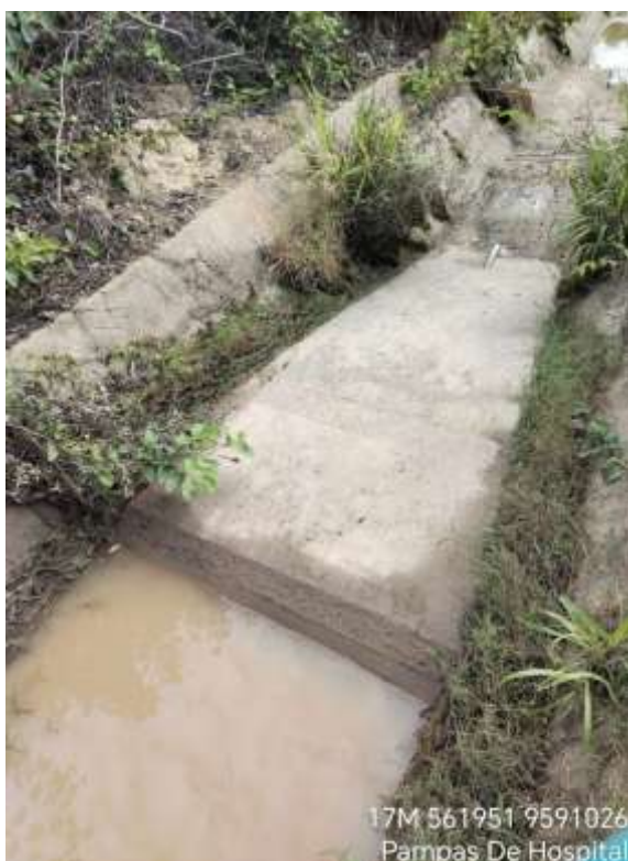
Figura 80: Evidencia 01 Medidor RBC
