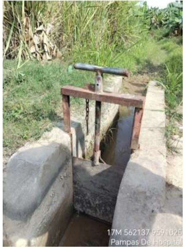
Figura 83: Evidencia 02 Compuerta Inicio L2
