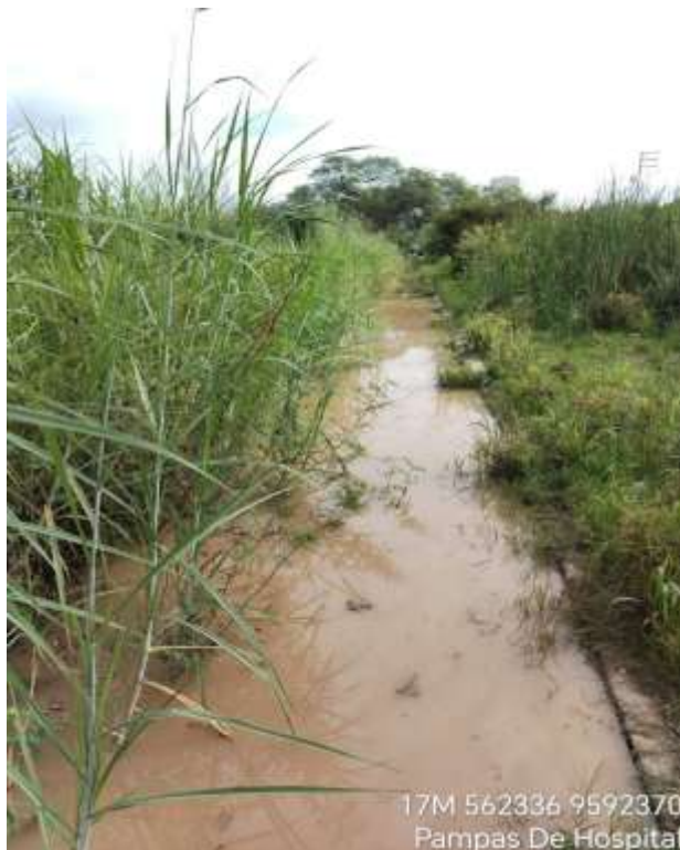
Figura 23, Tramo 09, canal de derivación
