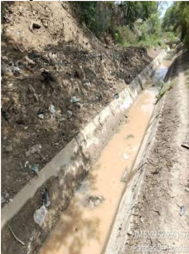
Figura 21, Tramo 07, canal de derivación
