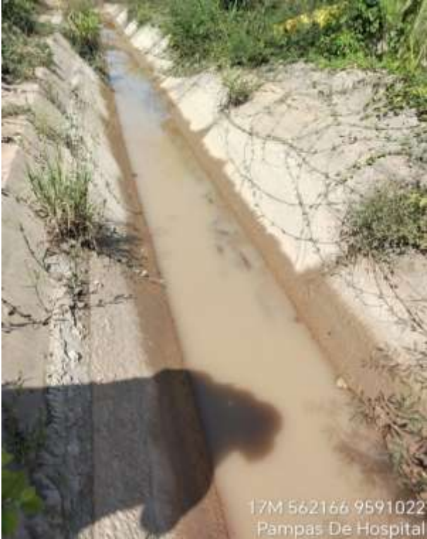
Figura 15: Tramo 02, canal de derivación
