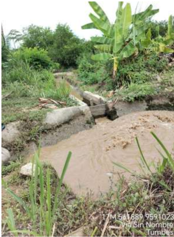
Figura 82: Evidencia 01 Compuerta Inicio L1
