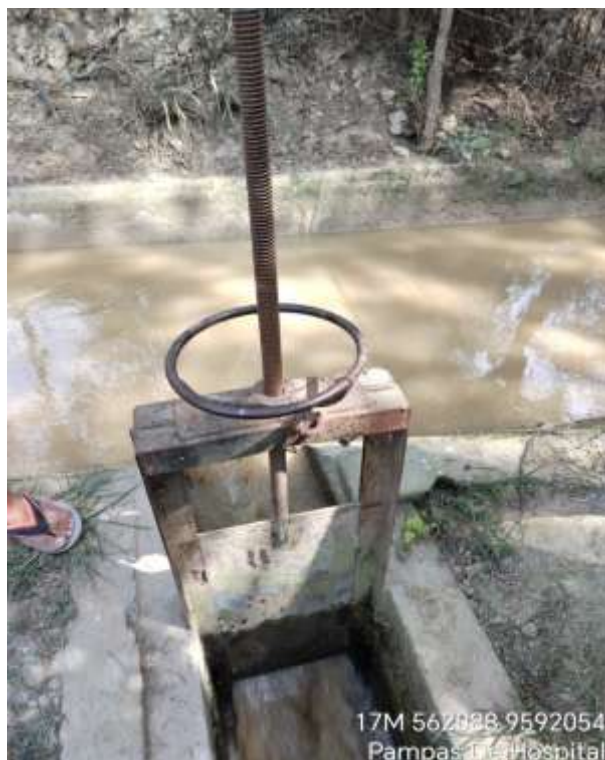
Figura 86: Evidencia 05 Compuerta Inicio L7
