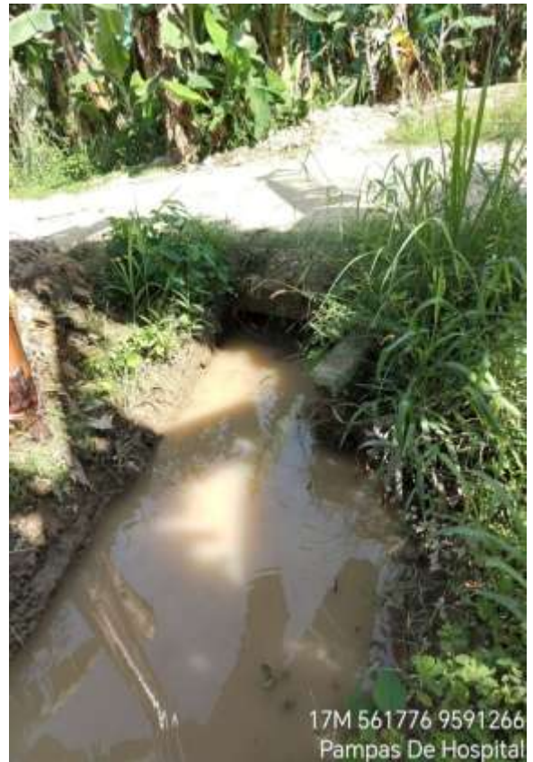
Figura 76: Puente N°5 Canal Lateral 1
