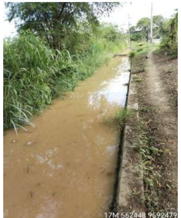
Figura 24, Tramo 10, canal de derivación
