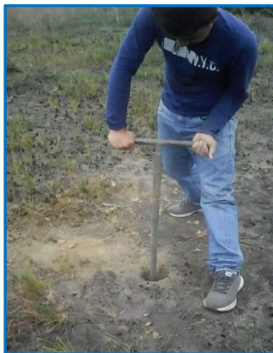
Foto 4: perforación de pozos con barreno
