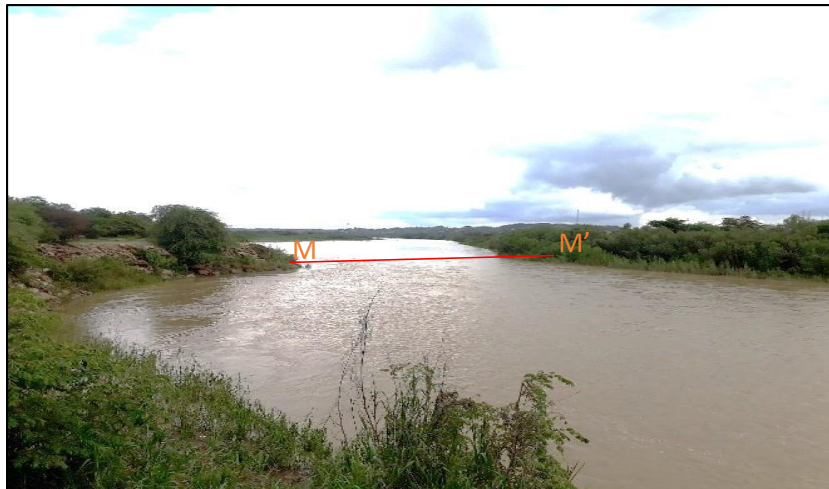
Figura 53.- Sección donde el flujo del agua llega a ingresar y producir velocidades máximas aguas abajo en la margen derecha
