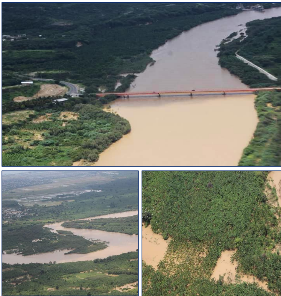
Figura 41. - Crecida del río Tumbes 05-03-2019. - sección puente de Francos (imagen superior), inundación de áreas agrícolas aguas abajo del puente Francos (imágenes inferiores)
