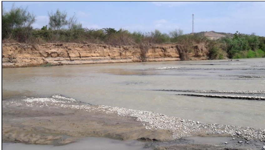
Figura 55.- Punto crítico donde se produce erosión en la ribera del sector de Cruz Blanca
