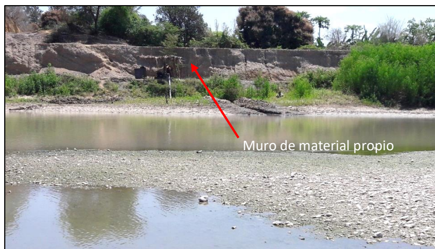
Figura 57.- Muro de material Propio del cauce en la margen izquierda.
