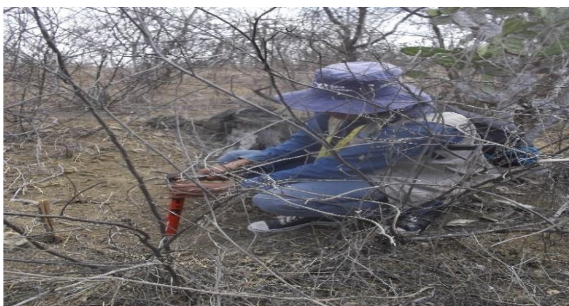
figura 29. Instalacion de estacas
