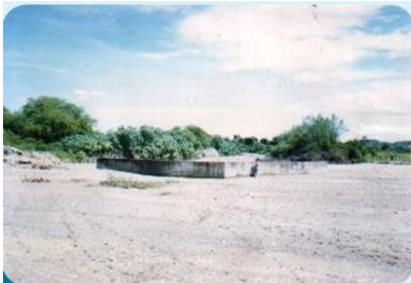
Foto N°9: Quebrada Urbina – Superpasaje Destruido
