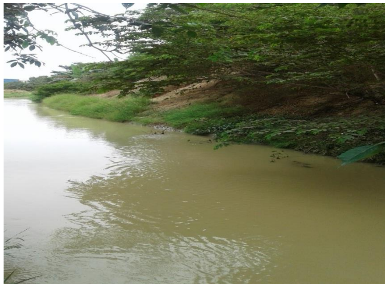
Foto N°2: Canal Pegado a Laderas de Cerros
