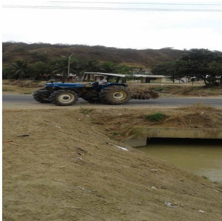
Foto N°4: Cruce Panamericana – Puente Pampa La Gallina
