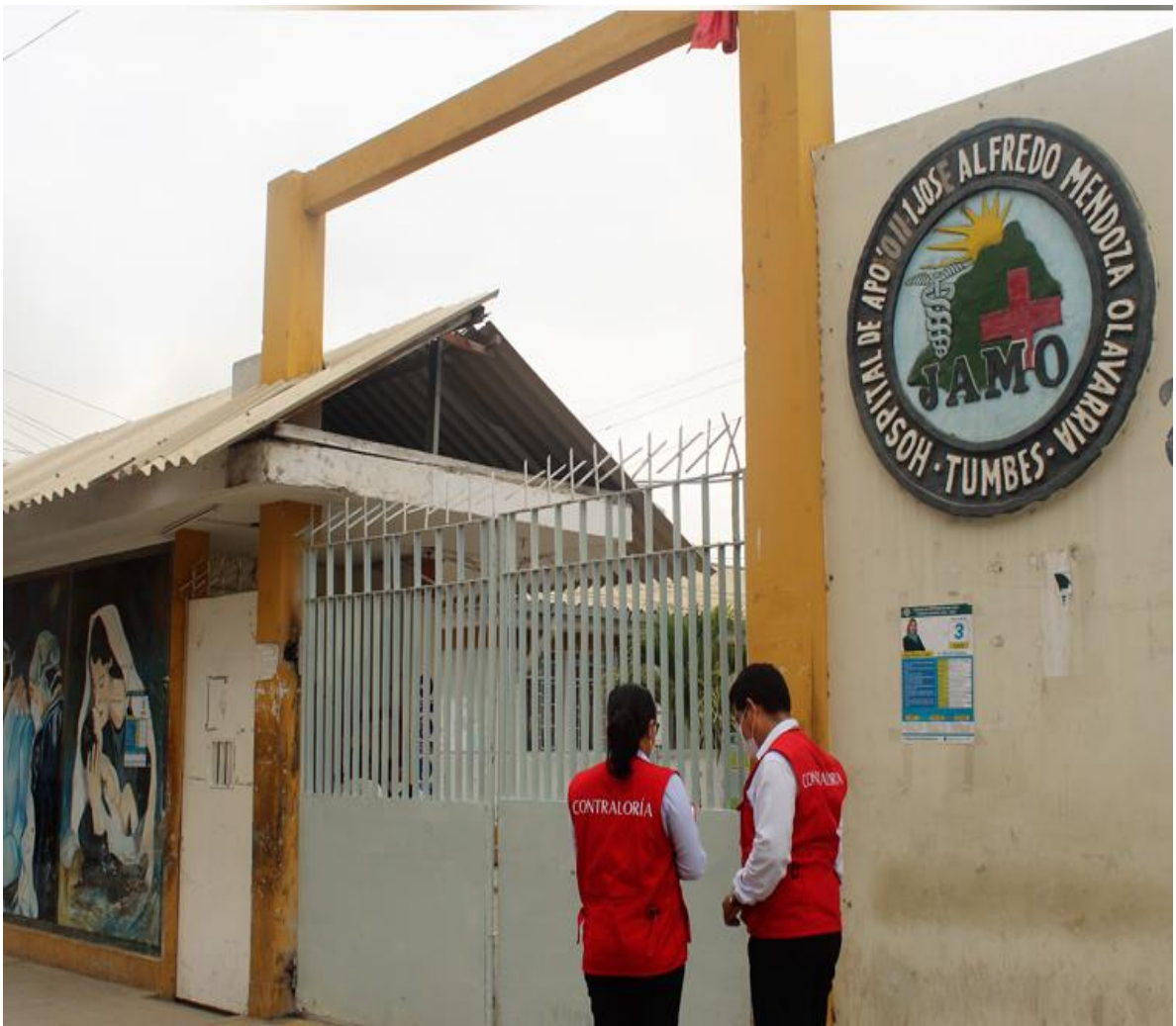
Foto 1: FACHADA HOSPITAL JAMOII-2-TUMBES
