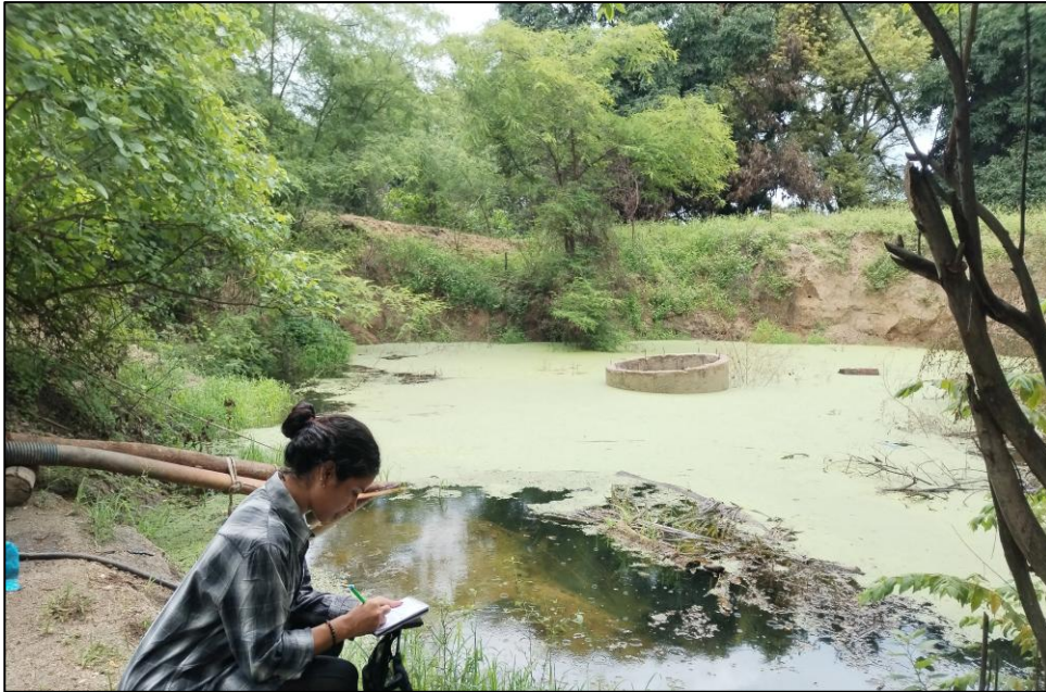
Figura 59: Pozo artesanal anillado de recarga natural y en funcionamiento.
