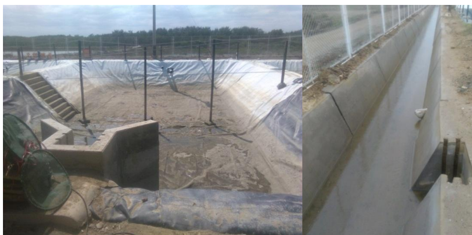
Figura 5. Inicio de la preparación y acondicionamiento del estanque.
