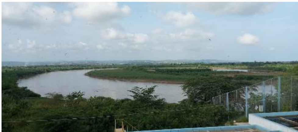
Captacion en PTAP (2023)
