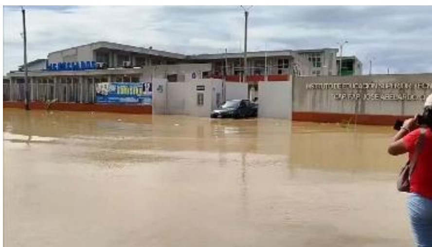
FIGURA 26. Inundación Pluvial (2025) en el Instituto Pedagógico
