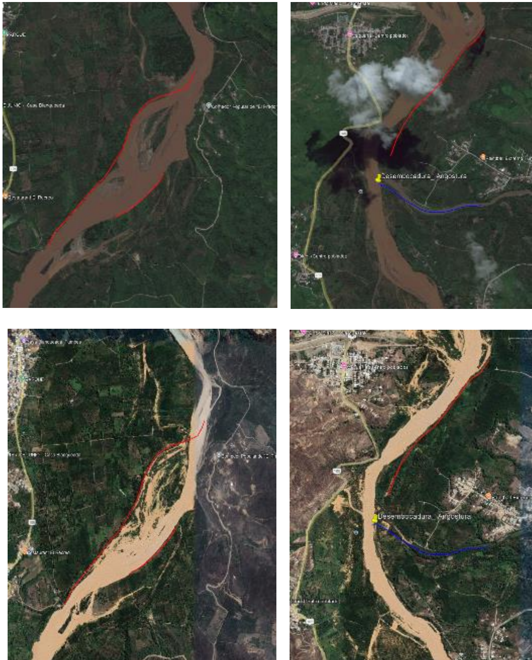
FIGURA 44. Comportamiento de la Infraestructura de protección ante eventos extremos: Imagen superior (Fenómeno el Niño 2017) e imagen Inferior (Ciclón Yaku 2023)
