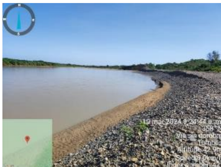
FIGURA 54. Acumulación de material grueso en ribera del Rio Tumbes + Sector Arena (Imagen 2024)
