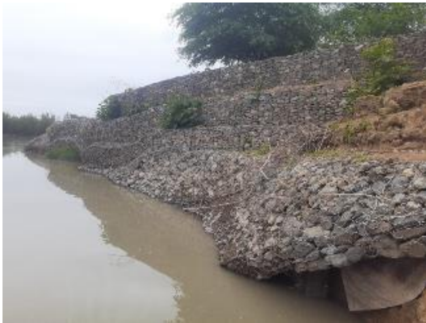
FIGURA 57. Gavión en la margen derecha del Río Tumbes (Imagen 2021)
