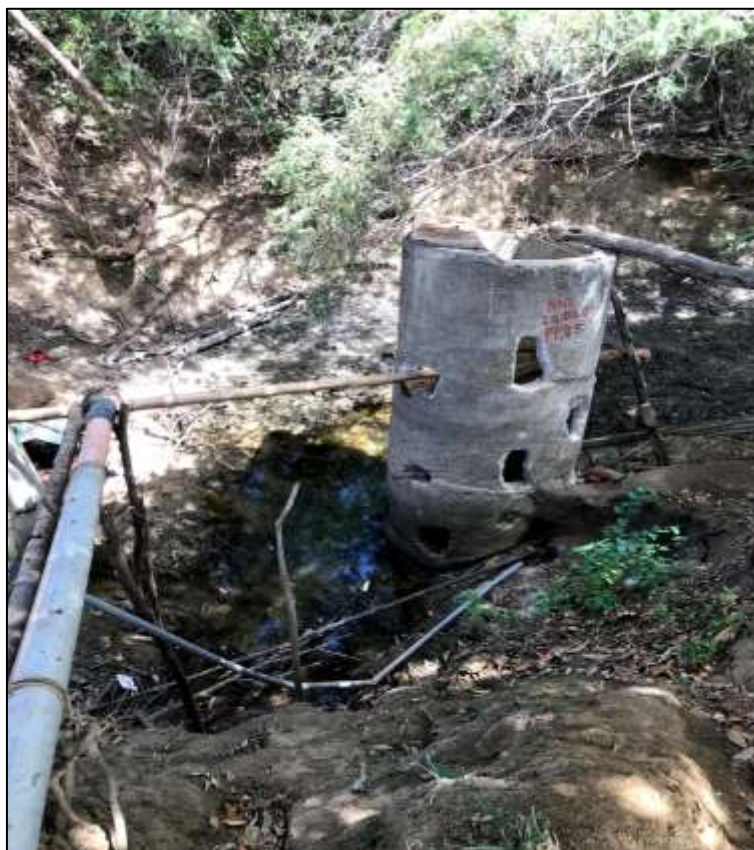
Anexo 3. Pozo a tajo abierto con anillos de concreto, en el sector San Carlos - Bellavista
