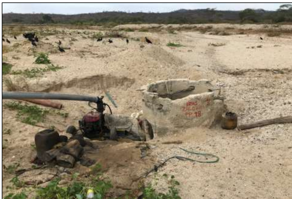
Anexo 3. Pozo a tajo abierto con anillos de concreto, en el sector San Carlos - Bellavista
