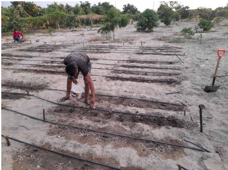
**Figura 13.** Instalación del sistema de riego por goteo
