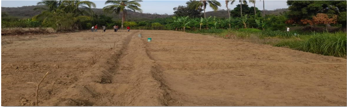
Preparación de terreno
