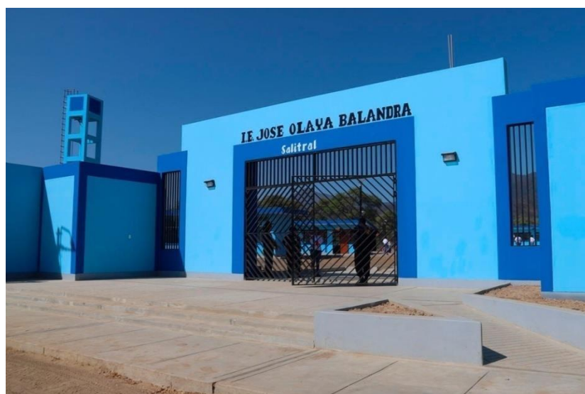
FACHADA DE LA IE “JOSÉ OLAYA BALANDRA” DISTRITO DE SALITRAL – MORROPÓN – PIURA, - 2020”
