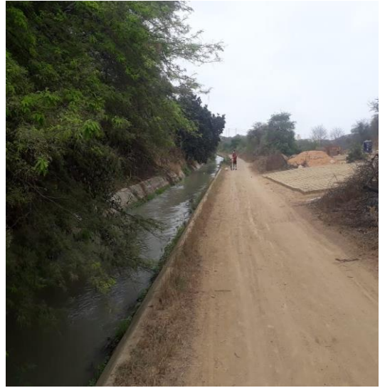
Foto N°. 10 Segundo Tramo
