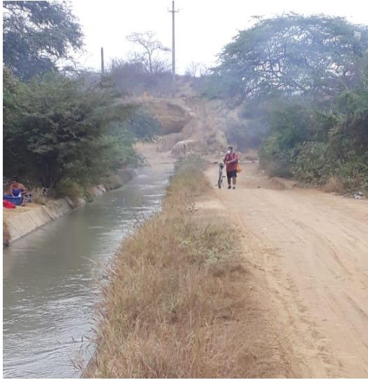
Foto N°. 9 Primer Tramo
