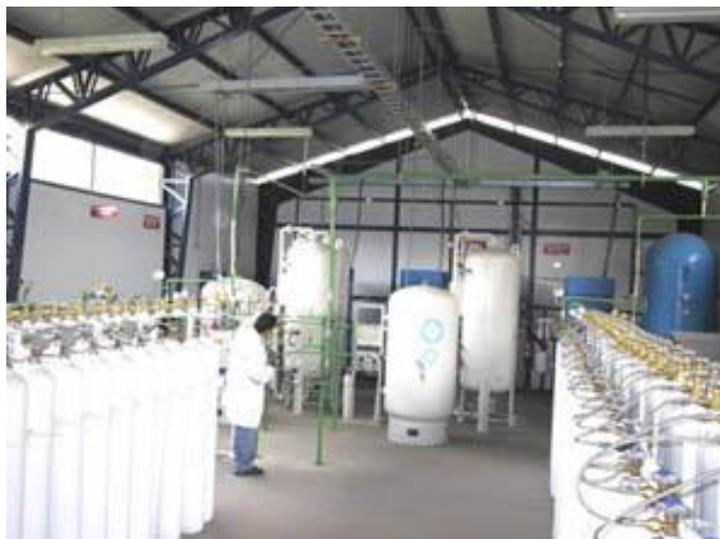
**Figura N° 4 Planta de oxígeno hospitalaria** <sup>37</sup>
