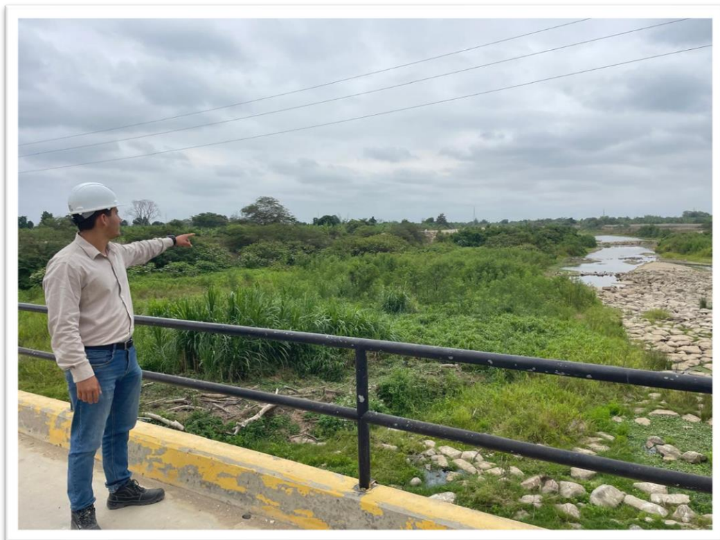
Foto 4. Se observa la escasez hídrica aguas abajo de la bocatoma La Palma
