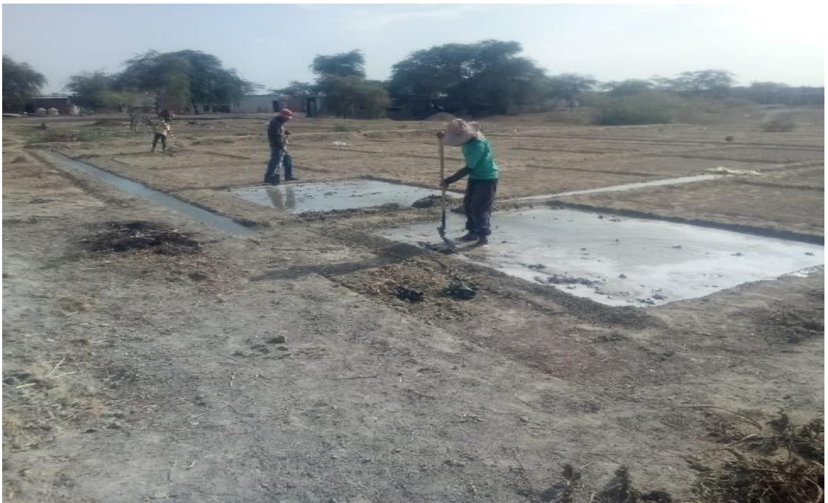
Figura 19 Realización el riego de machaco. Piura, 2023.
