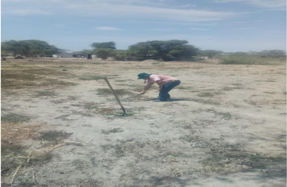
Figura 18 Ubicación y limpieza del terreno. Piura, 2023.
