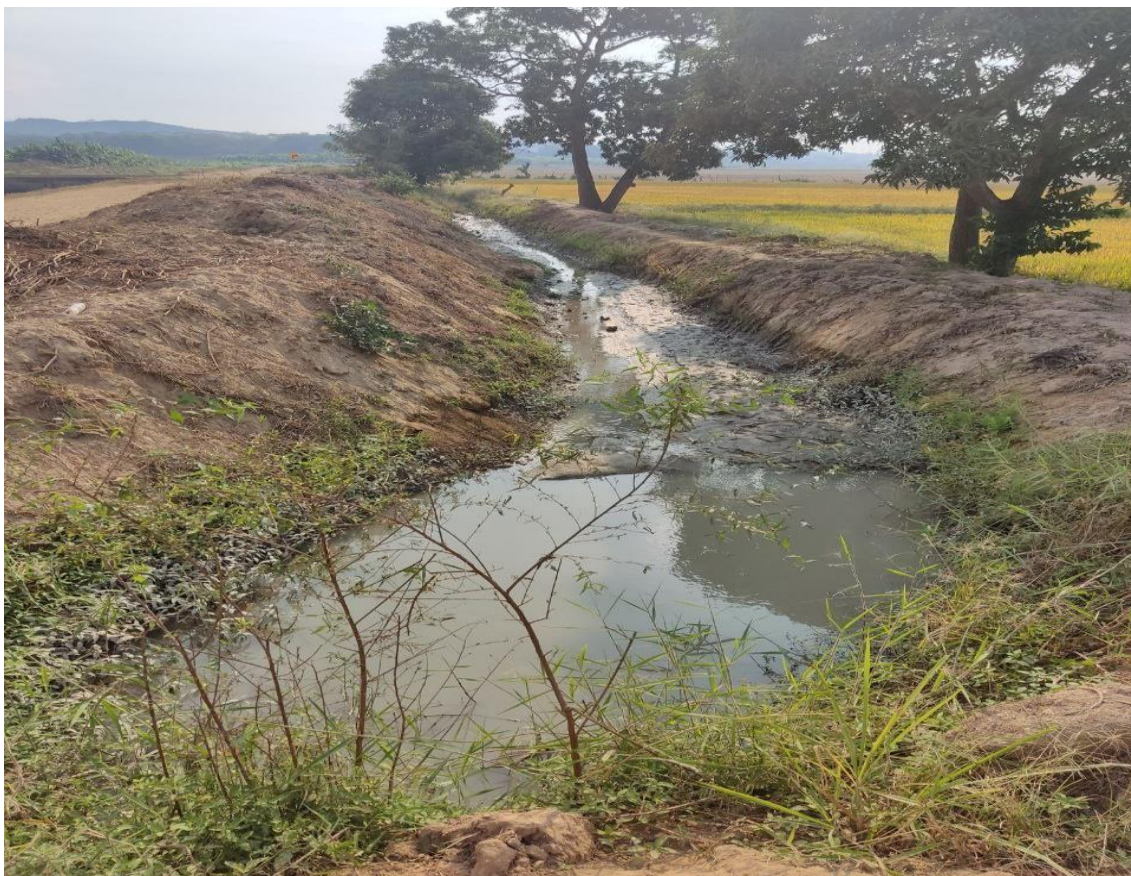
Figura 1 Canal en mal estado, del sector Pechichal - Malval
